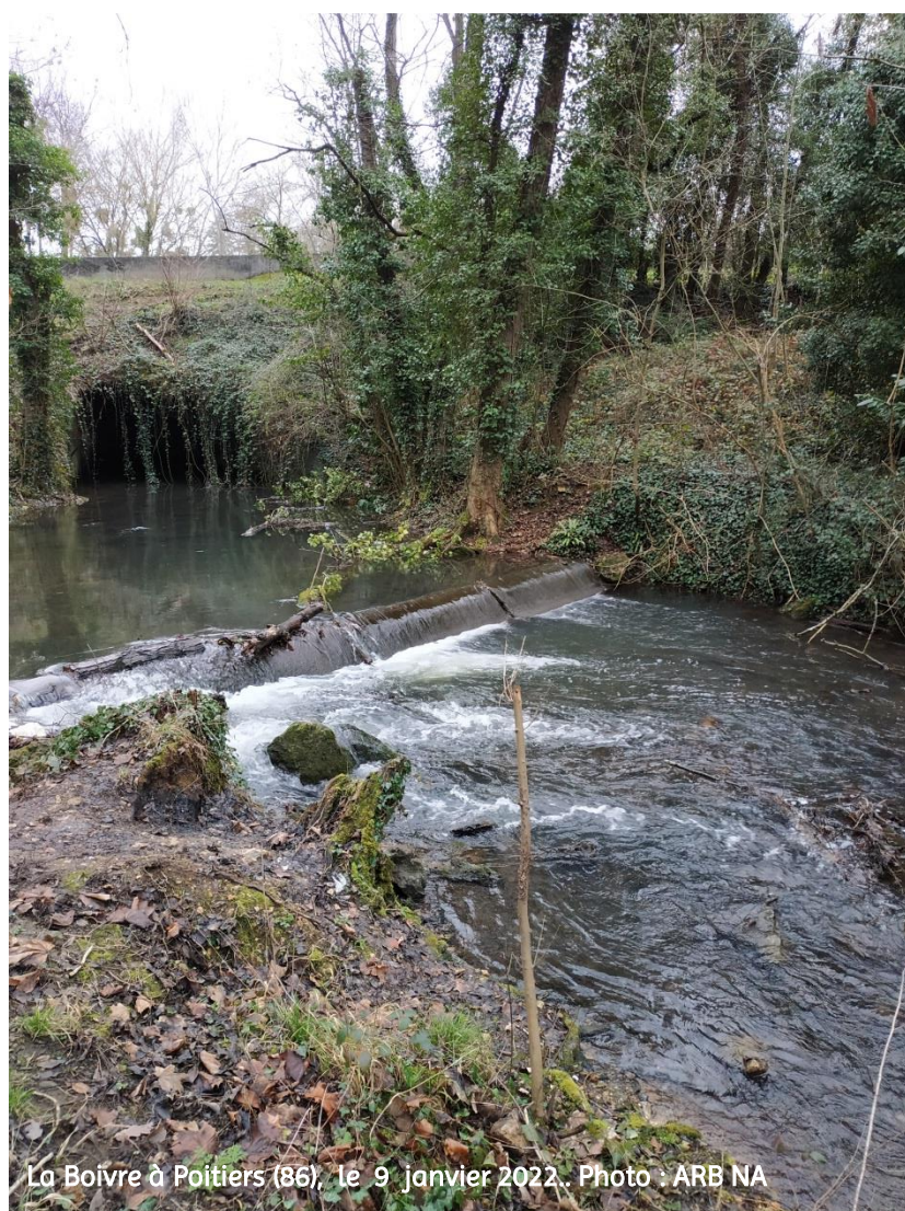
L'Auxance à Chasseneuil du Poitou (86), le 9 janvier 2022. Photo : ARB NA
