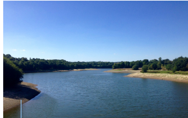
Barrage de la Touche-Poupard (79)
